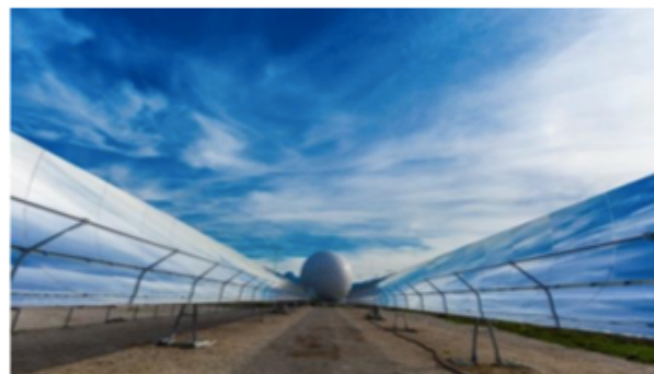
模块化设计的太阳能锅炉聚光发电交钥匙工程
